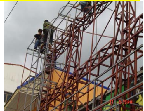
งานโครงสร้างต่าง ๆ
